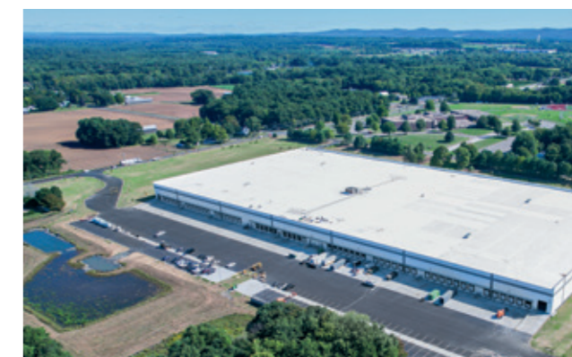
In Mailand eröffnete 2022 ein neues Kalibrierlabor (o. l.). Die indischen Eppendorferinnen und Eppendorfer freuten sich über das neue Office in Pune (o. r.). In Enfield, USA, wurde ein neues, hochmodernes Distributionszentrum errichtet (u.).
